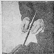
Рис. 9. Увеличение зазора в замке поршневого кольца
